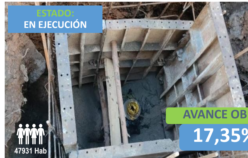
CONSTRUCCIÓN COLECTOR COVIBA CON ESTACIÓN DE BOMBEO
