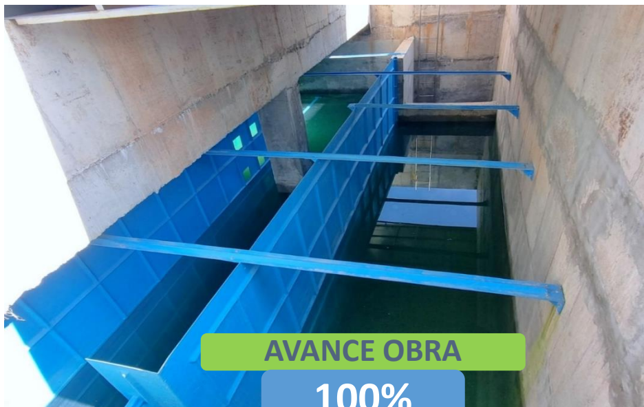
TANQUE DE CONTACTO DE CLORO
