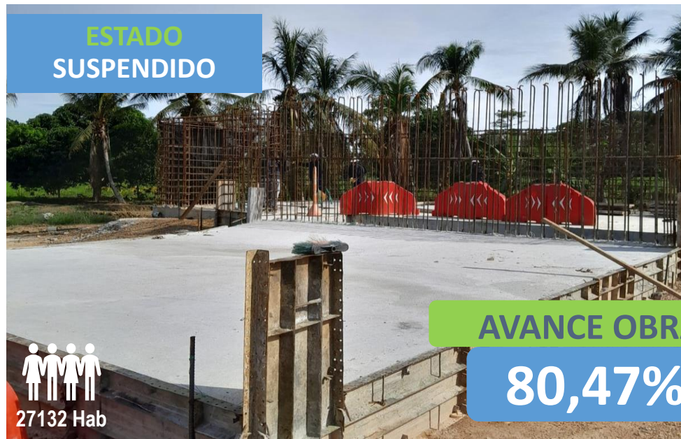
CONSTRUCCIÓN COLECTOR PARAISO CON ESTACIÓN DE BOMBEO
